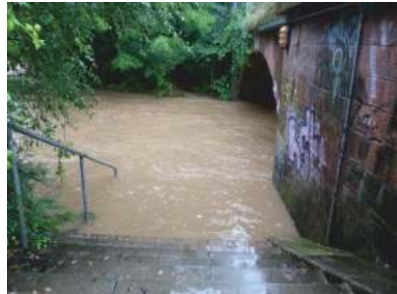
Wasserstand des Brettenbach hinter dem Gerätehaus in Emmendingen
