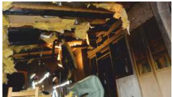
Brand eines Gasgrills mit Ausbreitung auf die Pergola und durch Abblasen der Gasflasche auf die Hausfassade
