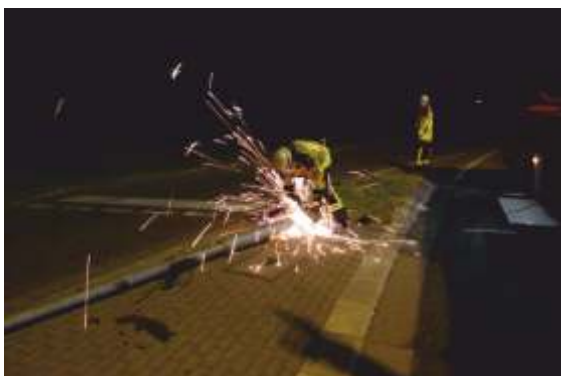
Beseitigung einer umgefahrenen Straßenlaterne
